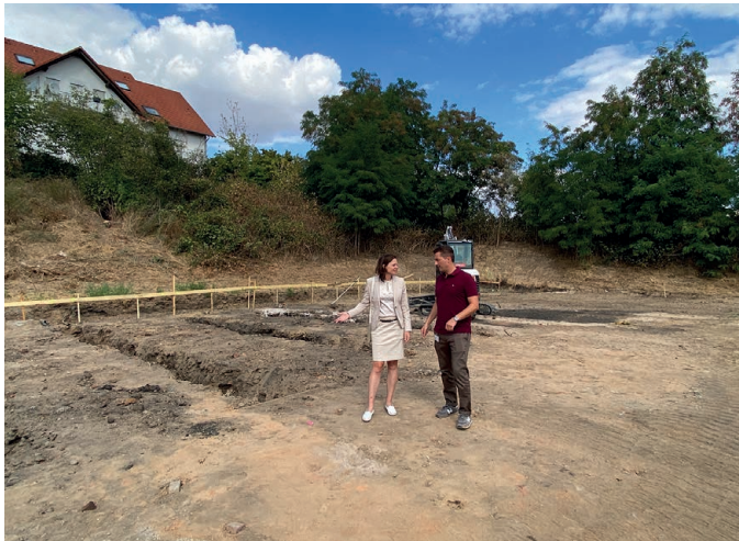
Bauarbeiten am Camp.
